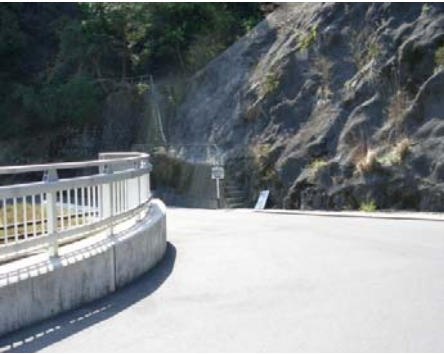
諭鶴羽ダムへの出口を逆方向から見たところでは、
